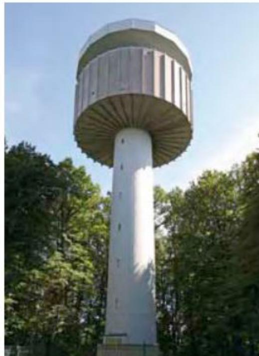
Der Wasserturm wurde zur Versorgung der Bergwaldsiedlung im Jahr 1967 erstellt. Er enthält zwei je 200 Kubikmeter fassende Ringkammern im oberen Teil des Turmes, sowie zwei je 20 Kubikmeter fassende Behälter im Fuß des Turmes. Der obere Wasserspiegel liegt bei NN+ 292 Meter, beziehungsweise 33,30 Meter über Gelände.
